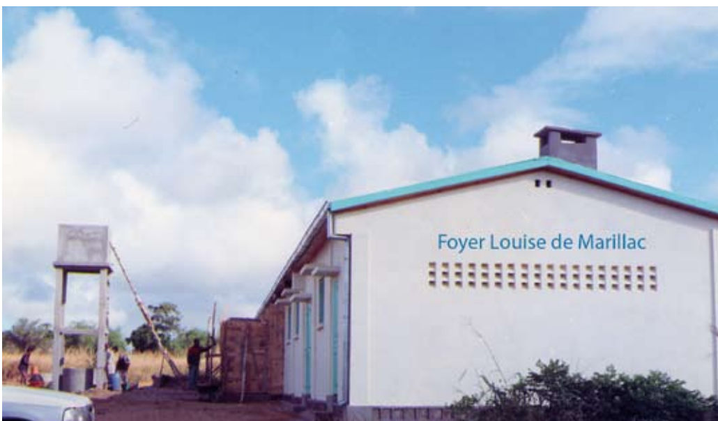
Analavoka: il fabbricato del foyer Santa Luisa ormai finito con il serbatoio d'acqua
