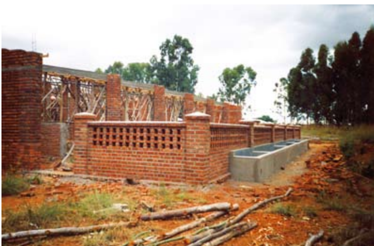
Jangany: la stalla in costruzione per ospitare 25 mucche
